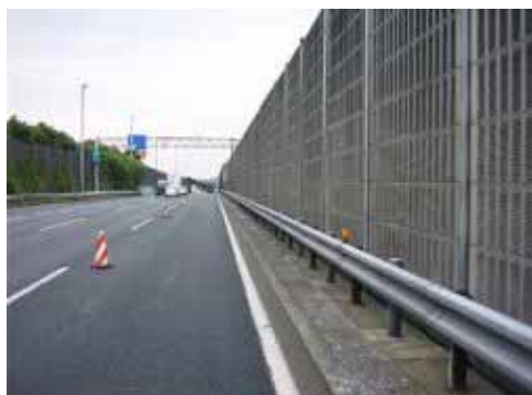
《中分防護柵(整備前)》
