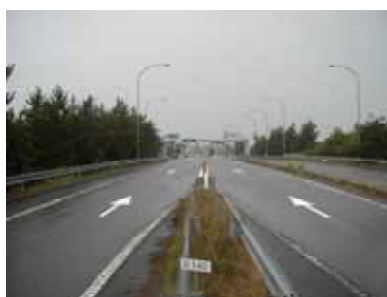
《逆走対策としての矢印路面標示》
