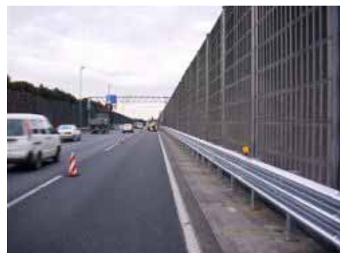
《強化型中分防護柵(整備後)》
