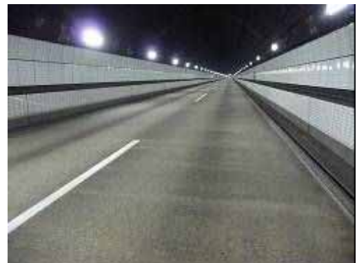
蛍光灯照明 関越道 関越トンネル
