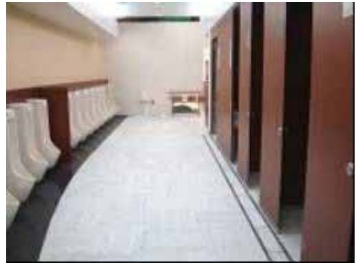
《トイレ内床の段差を解消》 関越道 三芳PA(上り)
