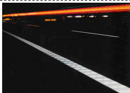
《夜間事故対策の高視認性区画線》
