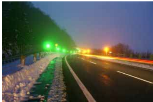
《自発光式視線誘導標の点灯状況》道央道 旭川管内
