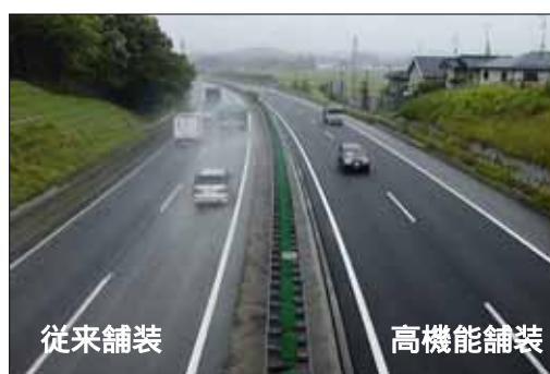
(雨天時における高機能舗装と通常舗装の状況)
