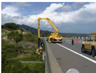
(橋梁の点検) 道央道 登別室蘭IC～登別東IC間
