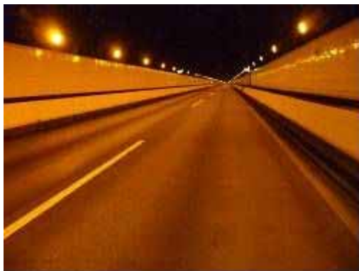
従来のナトリウム照明 関越道 関越トンネル
