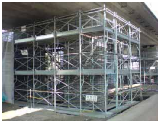
《施工状況》 道央道 大谷地高架橋
